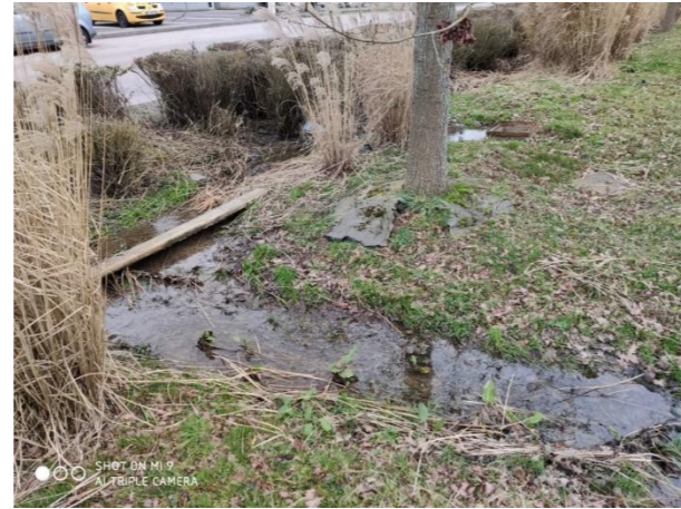
Figure 27 bv3 : Trop-plein aval ZAC (réf : 2020-02-05_17-07-53)
