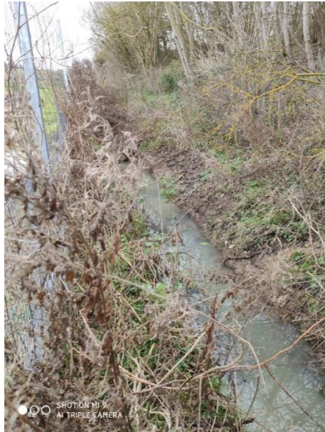
Figure 35 bv4 : Aperçu du talus de remblai de l'A13 (réf : 2020-02-05_14-34-42)
