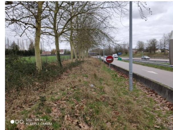
Figure 21 bv1 : Aperçu de la bretelle d'entrée de l'Aire de Vironvay (sens Paris-Rouen) (ref : 2020-02-05_16-39-48)
