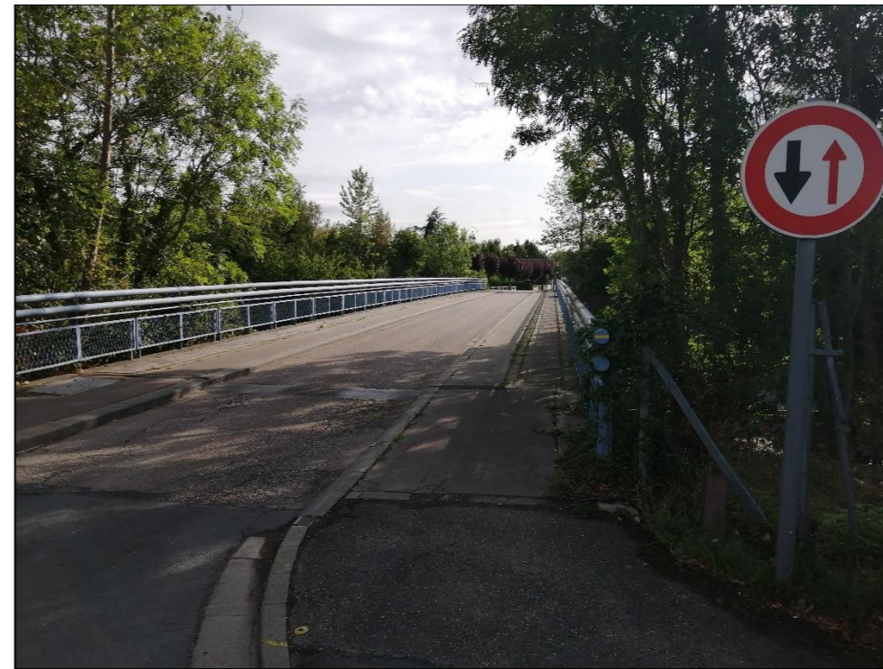
Figure 11 : Vue n°5 (Source : Egis, 13/08/2019)
