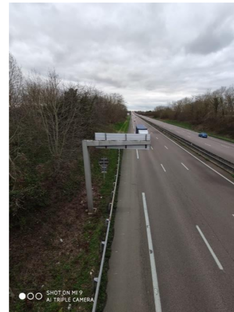
Figure 19 bv1 : Aperçu de l'assainissement lateral A13 (PS Vironvay) (ref : 2020-02-05_16-47-42)
