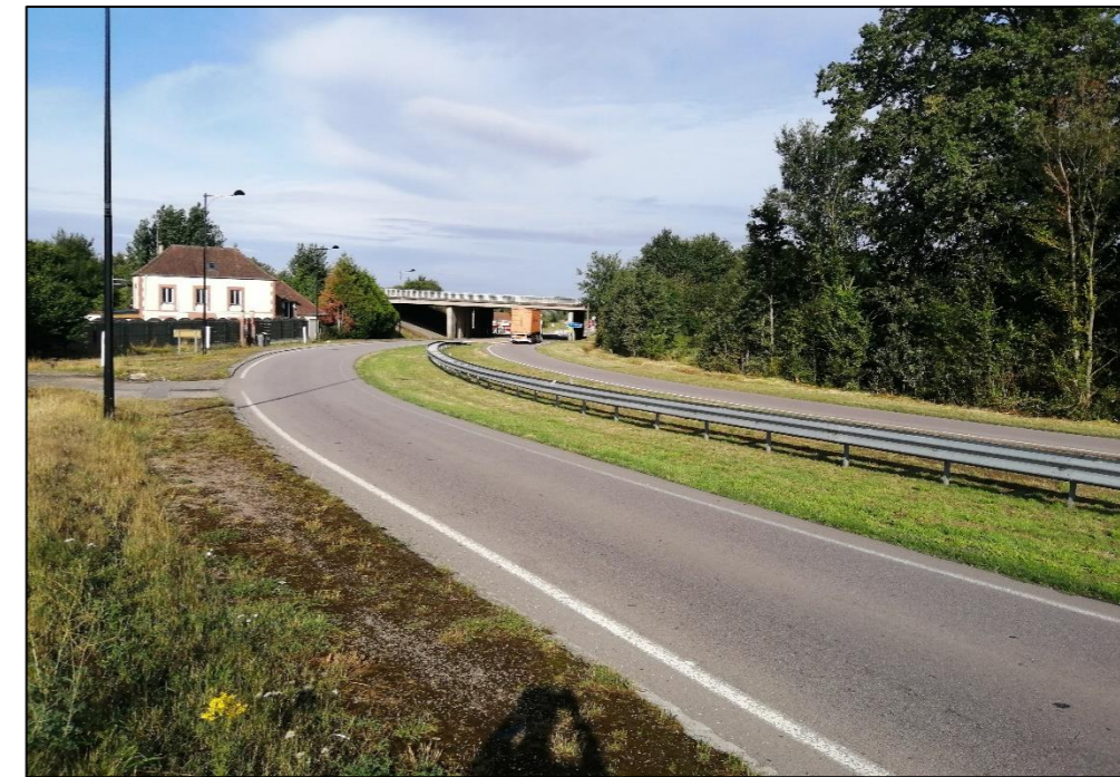
Figure 7 : Vue n°1 (Source : Egis, 13/08/2019)
