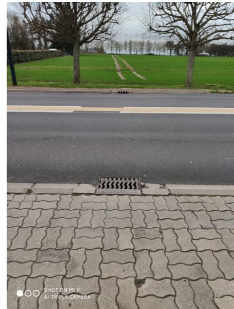
Figure 18 bv1 : Vue du point bas de la RD (ref : 2020-02-05_17-37-04)
