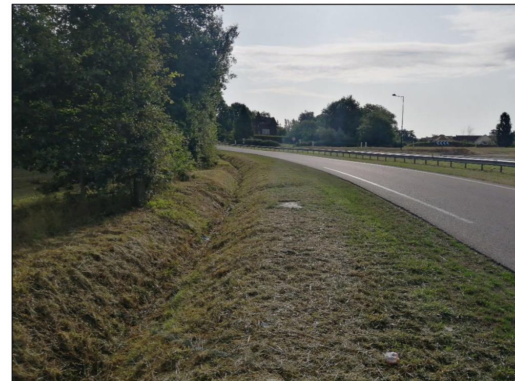
Figure 8 : Vue n°2 (Source : Egis, 13/08/2019)
