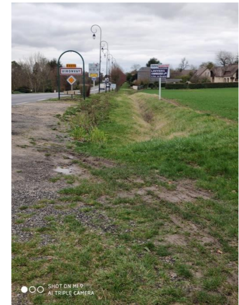
Figure 20 bv1 : Fossé lateral amont RD en direction de Vironvay (ref : 2020-02-05_16-44-42)
