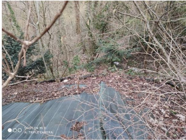
Figure 15 : bv1 Vue du D500 PVC chez le riverain aval (ref : 2020-02-05_17-50-40)
