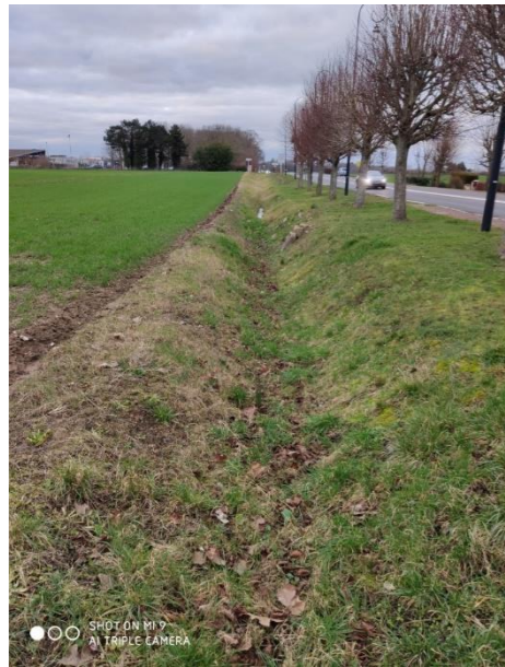
Figure 17 bv1 : Vue du fossé de la RD en direction de l'aire de Vironvay (ref : 2020-02-05_17-37-47)
